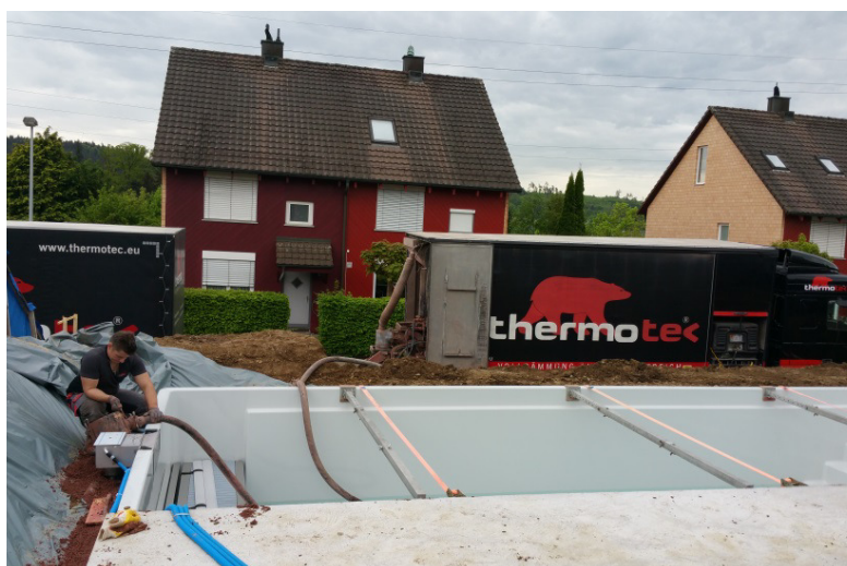
Schwimmbad hinterfüllen mit Thermotec
