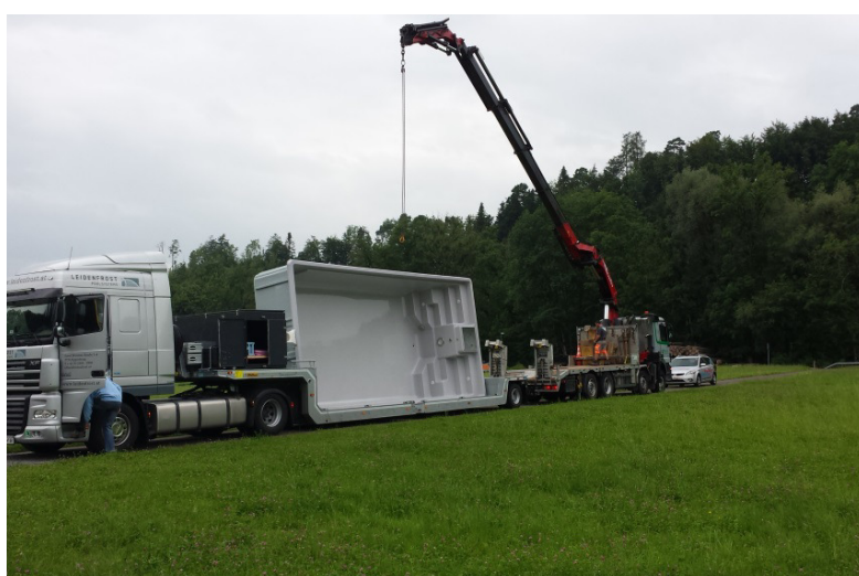
Versetzen des Leidenfrost Pool's mit Kran
