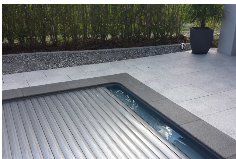
Beckenumrandung fertig erstellt
