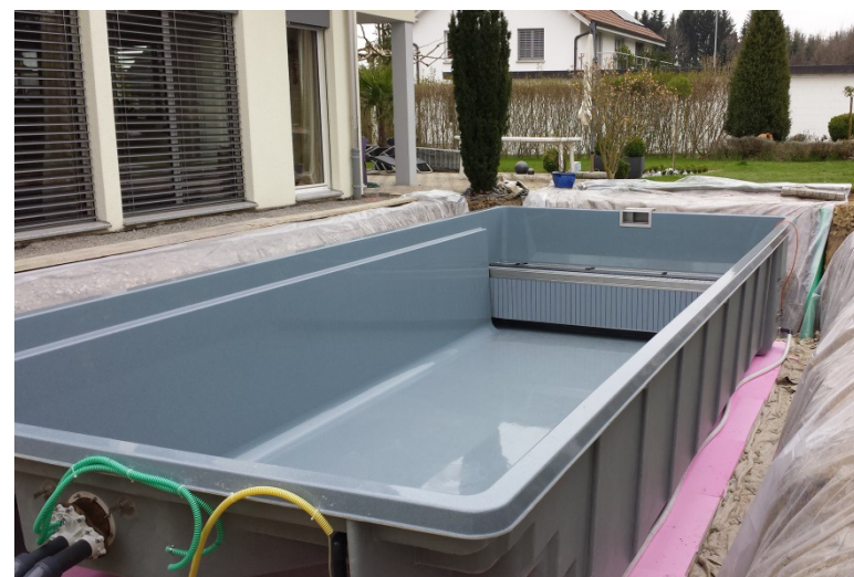
Verlegen der Badewasserleitungen
