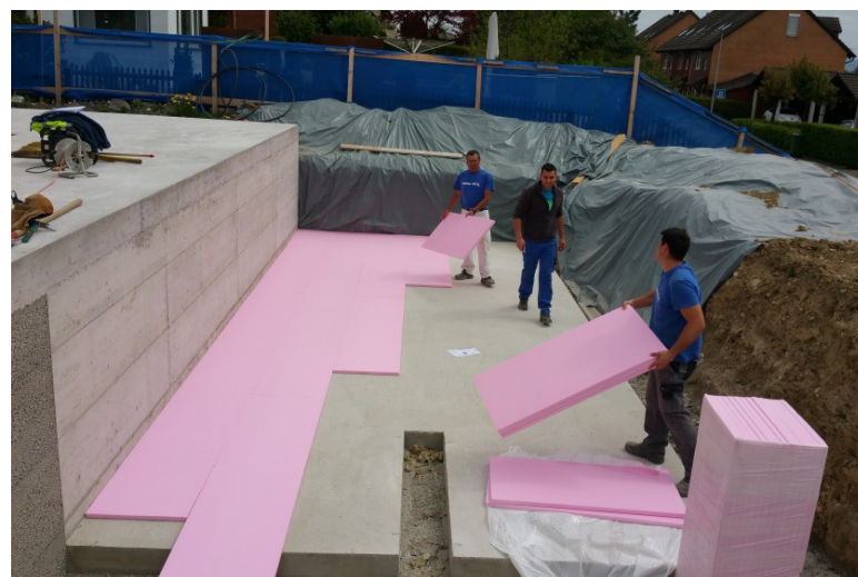
XPS-Isolationsplatten auf Bodenplatte
