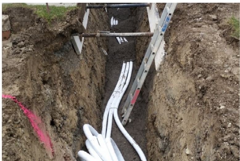
Leitungsgraben zum Technikraum
