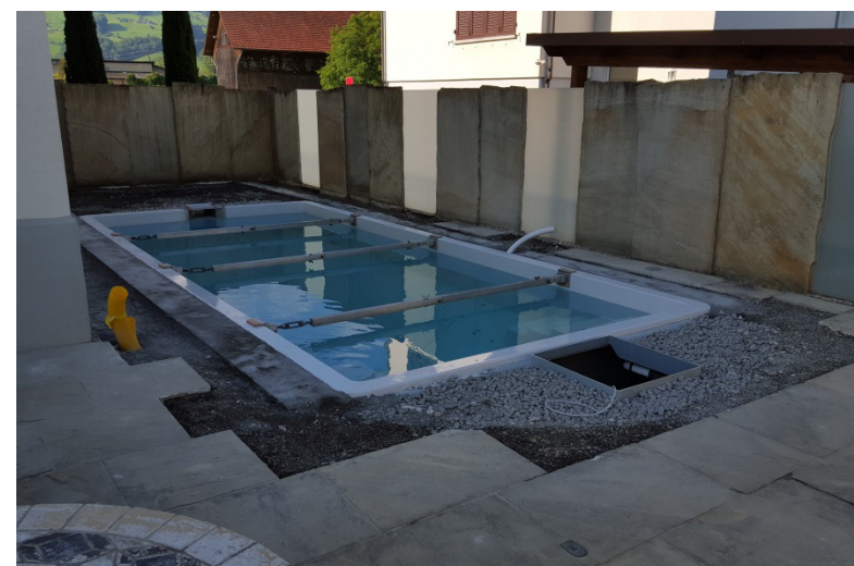
Rohplanie und Fundament für Umrandung
